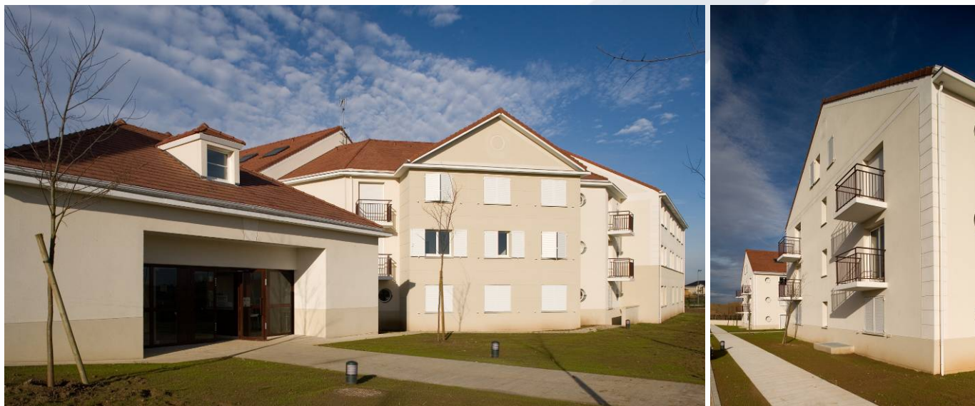
Réalisation d'une résidence pour étudiants
