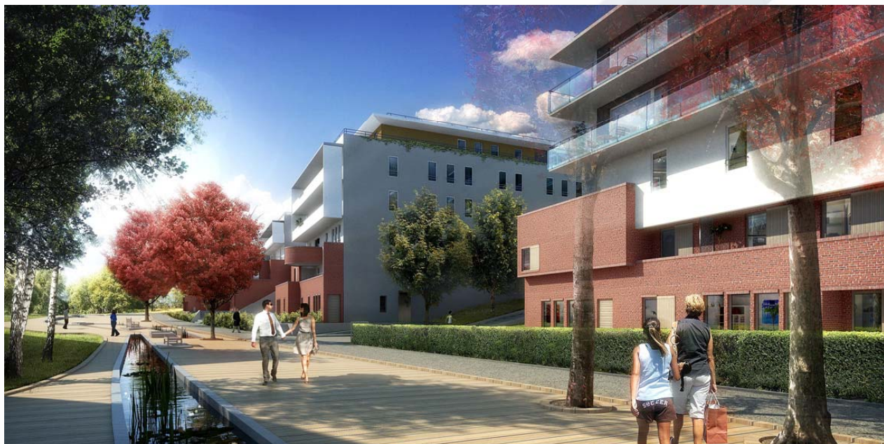
Construction de logements collectifs, label THPE EnR
