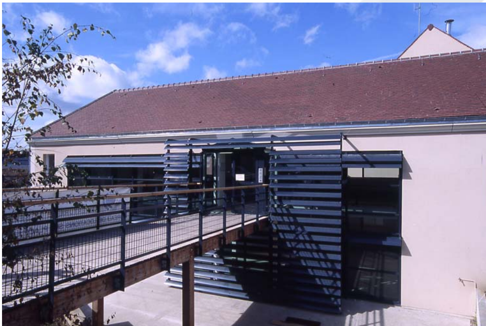
Construction d'une résidence pour étudiants (1 794 m 2 )
