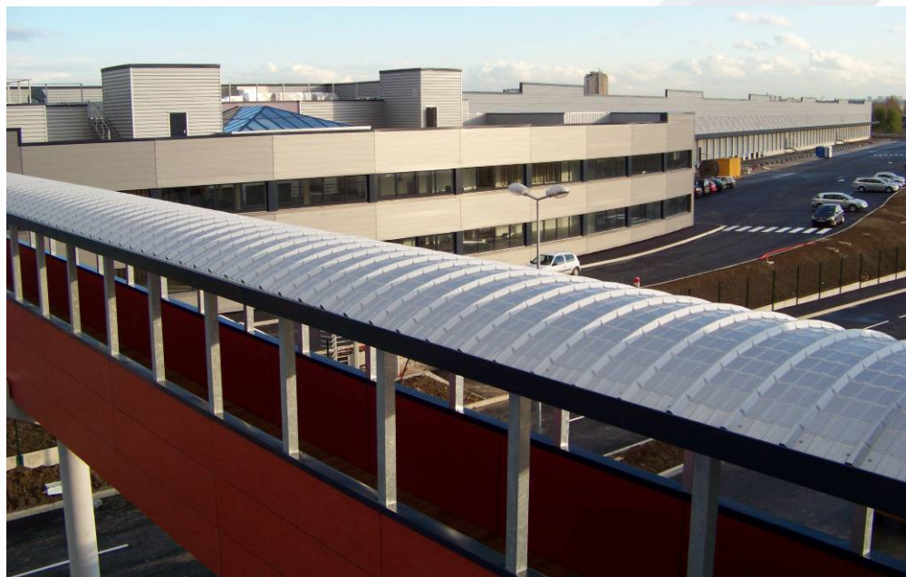
Réalisation d'un entrepôt et d'un bâtiment de messagerie
